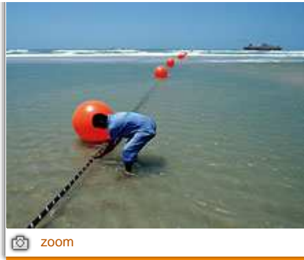
L'Afrique sur le chemin du câblage
